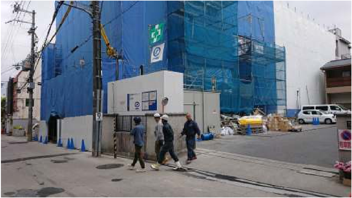
乾淨的施工現場與完善的安全防護(三)
