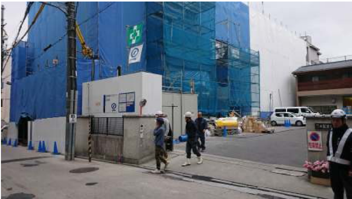
乾淨的施工現場與完善的安全防護(二)
