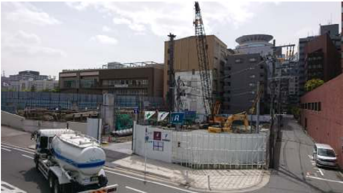
乾淨的施工現場與完善的安全防護(四)
