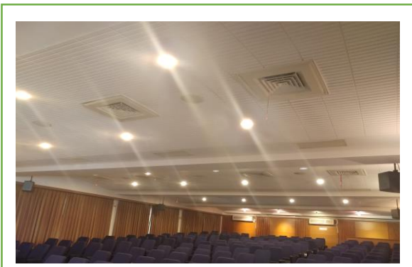
3樓演藝廳 施工前
