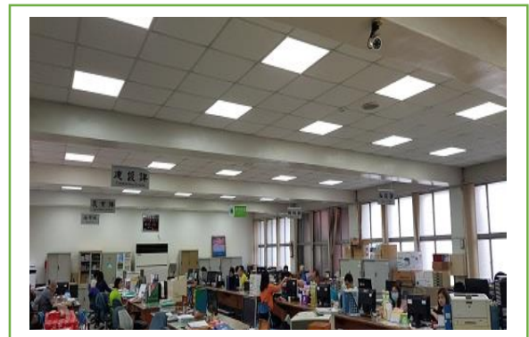
1樓綜合辦公室 施工後
