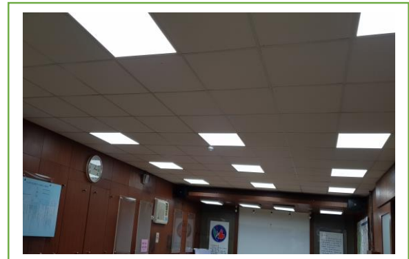
2樓資料中心 施工後
