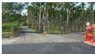
圖 4-2-4 永春巷路面改善
