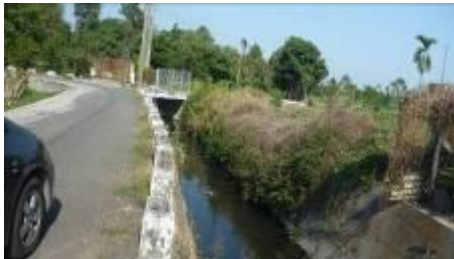
圖 4-2-7 泰安巷排水改善
