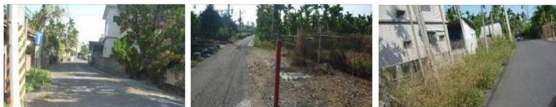
圖 4-2-1 泰安巷路面改善
